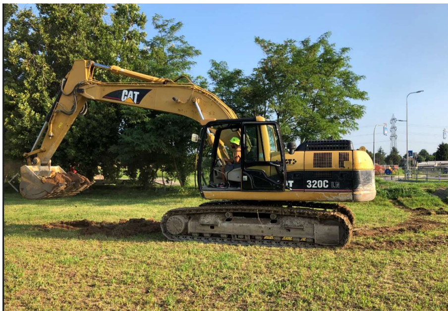
Figura 15 – Esecuzione Pozzetto n.2
