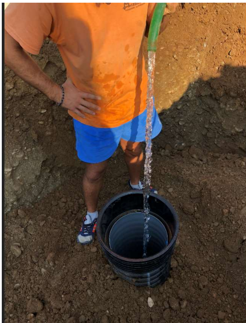
Figura 16 – Esecuzione prova di permeabilità
