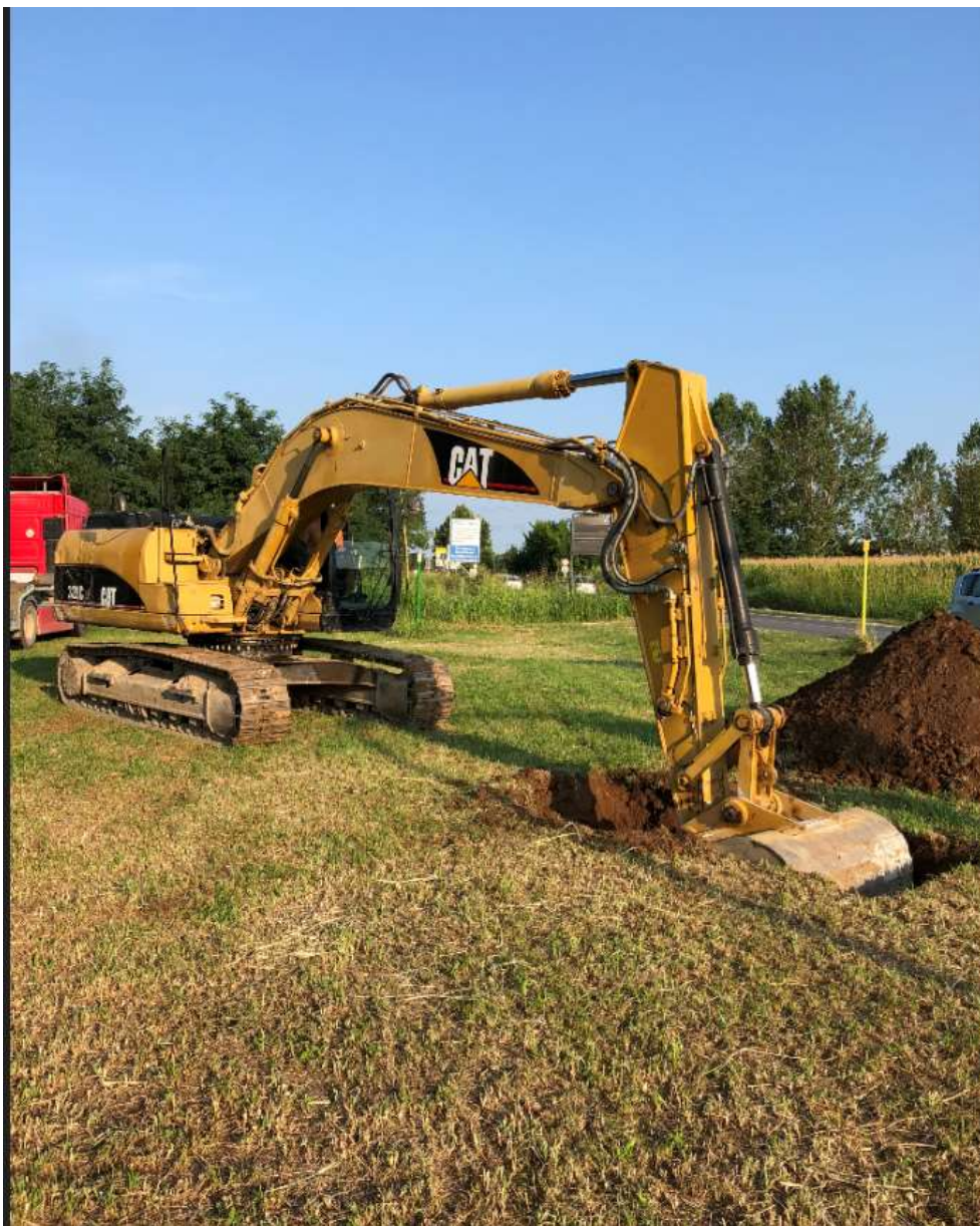
Figura 12 – Esecuzione pozzetto n.1
